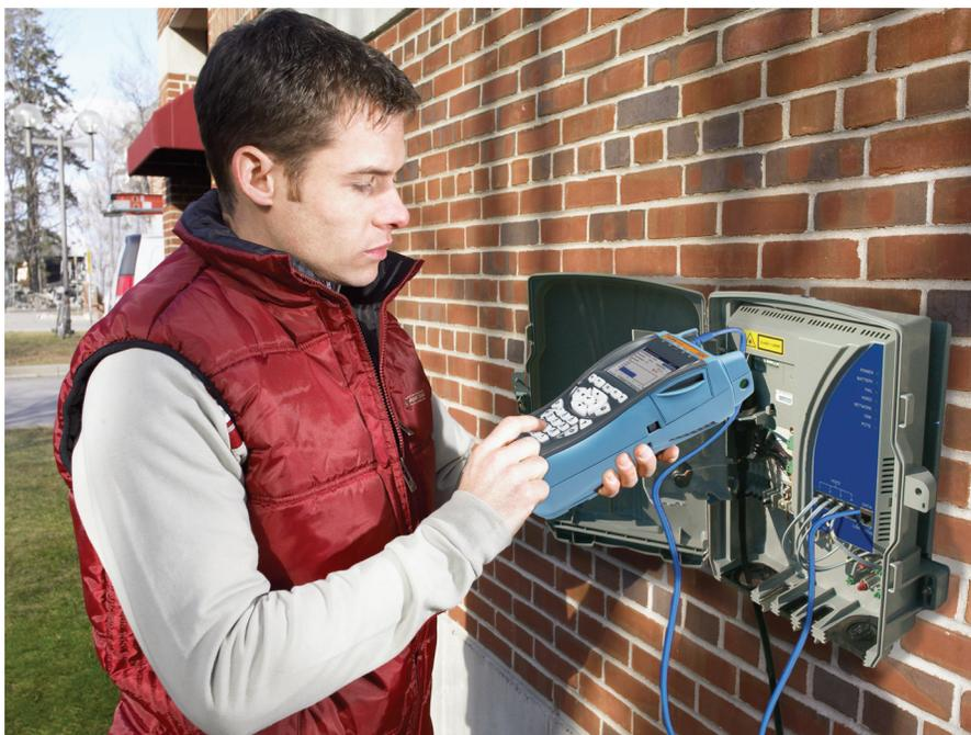
Тестирование IPTV на выходном порте Ethernet оптического сетевого терминала.
